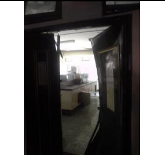
圖 8. 受災後之門窗(此為對面實驗室門，儀器室門炸飛撞及對面門導致)
