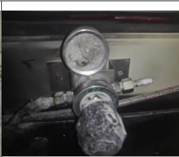
圖 2.瓦斯管路接頭纏有止水帶，更易鬆脫
