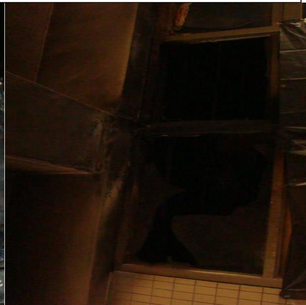
圖 3 疑似起火點(此點為瓦斯導管燒損後自 5 公斤鋼瓶出氣及造成噴焰續燒可能氣體洩漏點)
