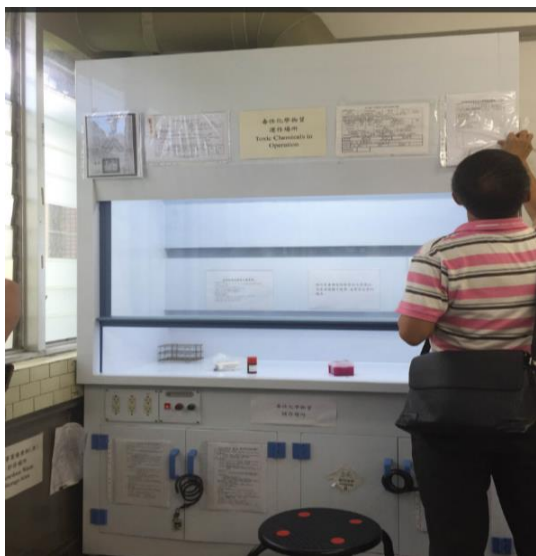
圖 3. 抽風櫃下方不宜儲放化學藥品(如儲放應設置抽氣裝置)
