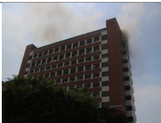
圖 2、事故大樓(實驗室)
