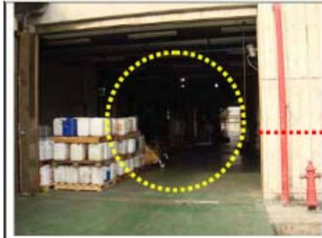
廠房內設備位置(陰暗)
