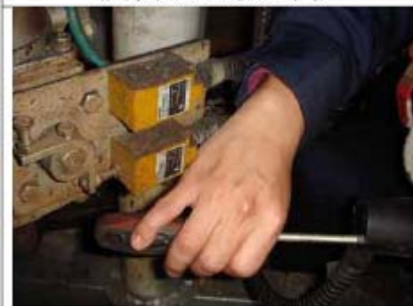
徒手拆解熱感知器外蓋螺絲(模擬)
