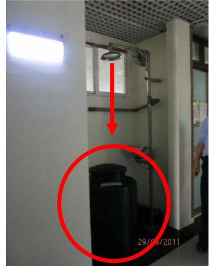
圖 6、實驗室外緊急沖淋設備未定期維護(水壓過強)
