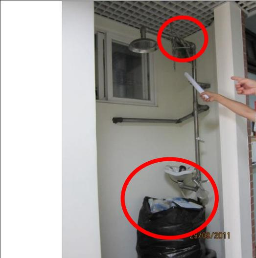
圖 7、實驗室外緊急沖淋設備位置堆放物品
