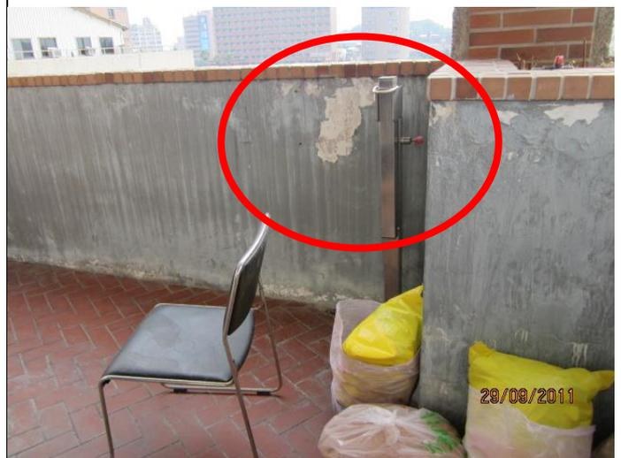
圖 8、實驗室外緊急沖淋設備位置堆放物品且拉環無法使用
