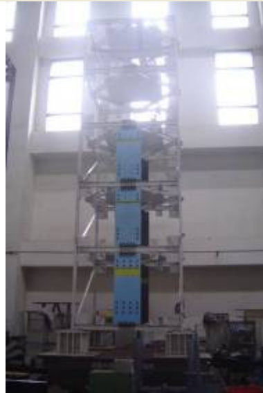
大型實驗構架無適當之爬梯
