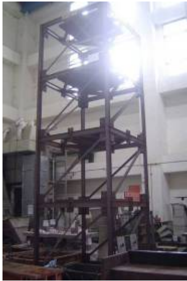
大型實驗構架無適當之爬梯
