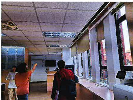
A700b 雙語教學研究中心天花板骨架及板材脫落
