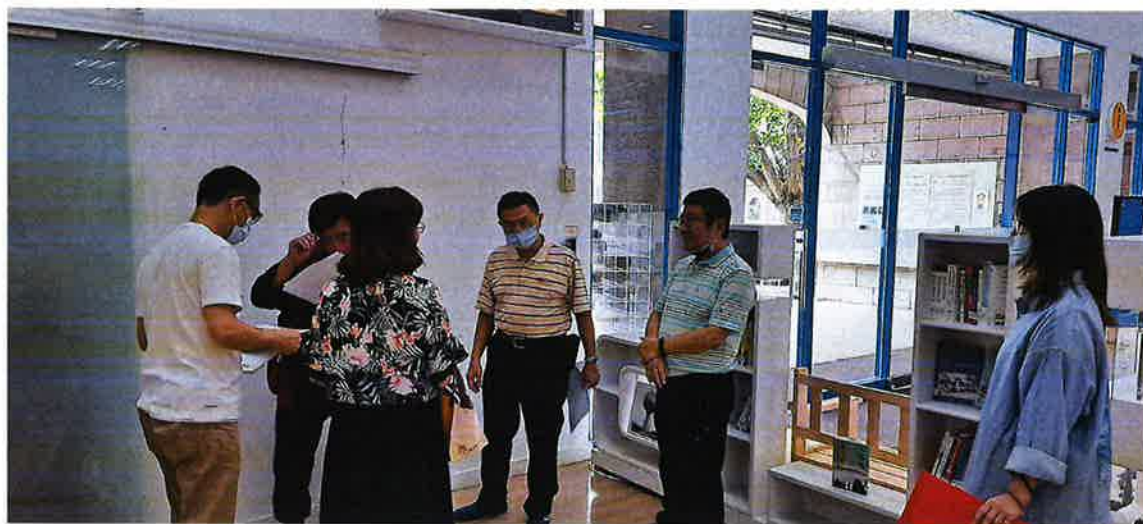
圖書館牆面龜裂
