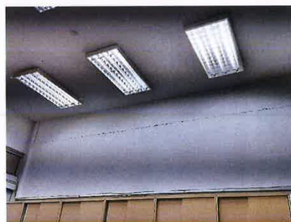
A101 總務處事務組牆面龜裂及前方走廊牆面磁磚剝落
